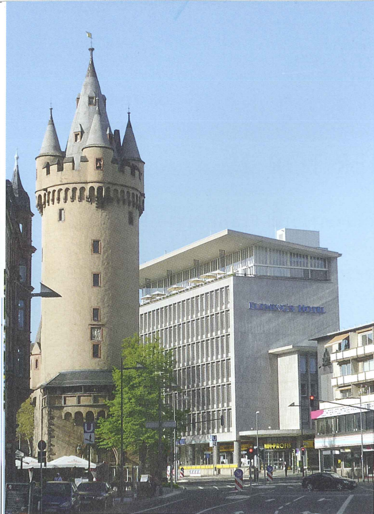
Abb. 3 Südansicht, Dach mit Technikaufbau, Vorzustand, 2011
