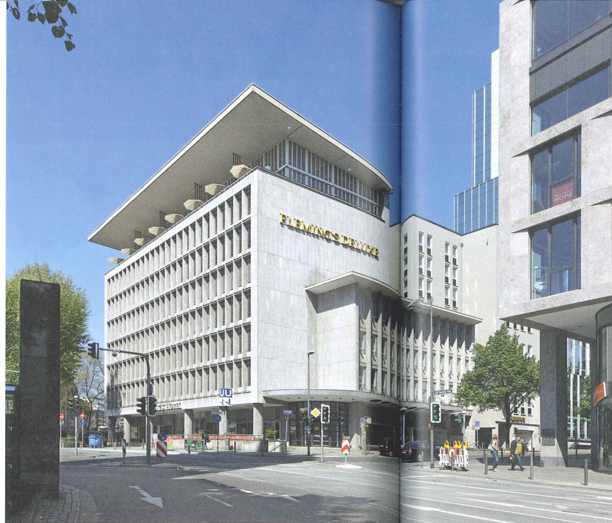
Abb. 4 Südansicht, nach Entfernung des Technikaufbaus, 2017
